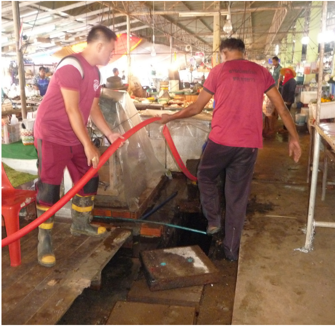
ทำความสะอาดฉีดล้างครุข่ายน้ำตลาดสดทุ่งยาว
